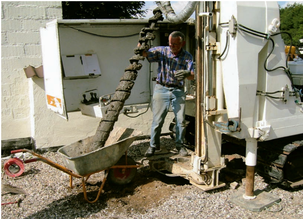
Figur 2 Udtagning af jordprøver fra boring
