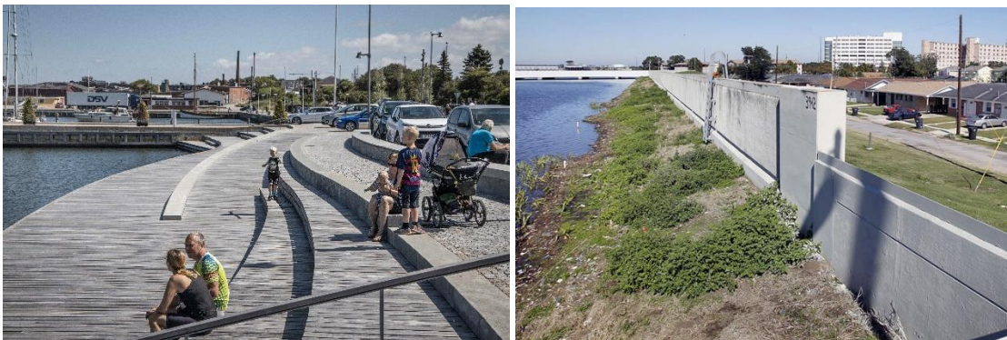
Stormflodsbeskyttelsen i Struer med lav mur samt til højre et "skræmmeksempel" fra New Orleans
