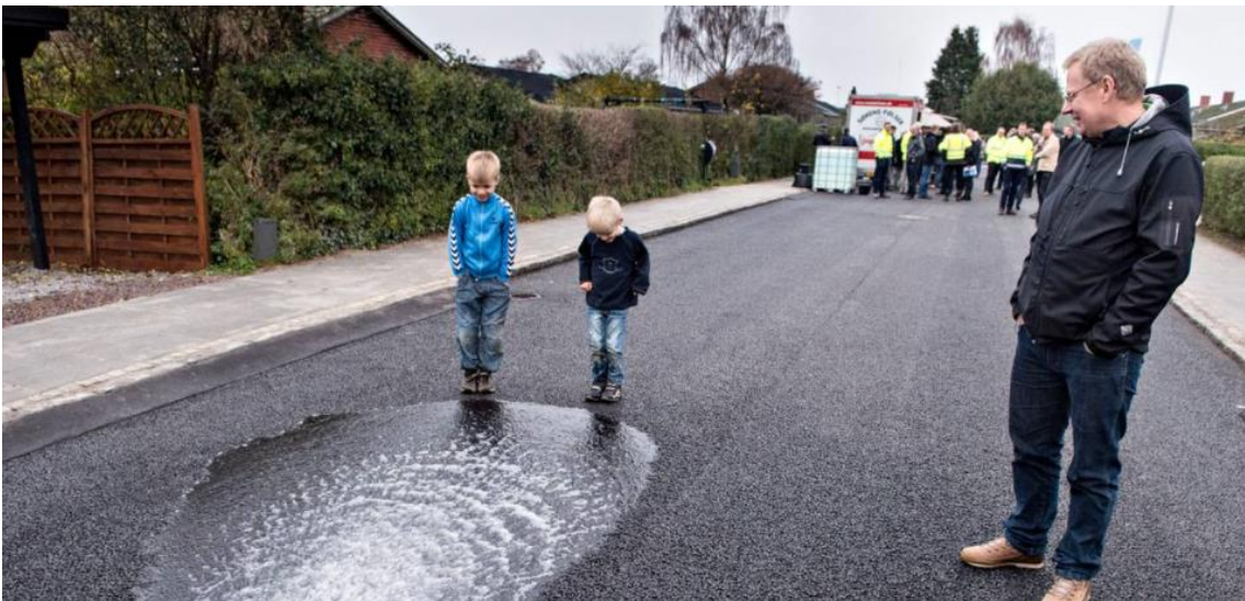
Agerlandsvej i Odense var den første med permeabel belægning og magasinering i selve vej-kassen
