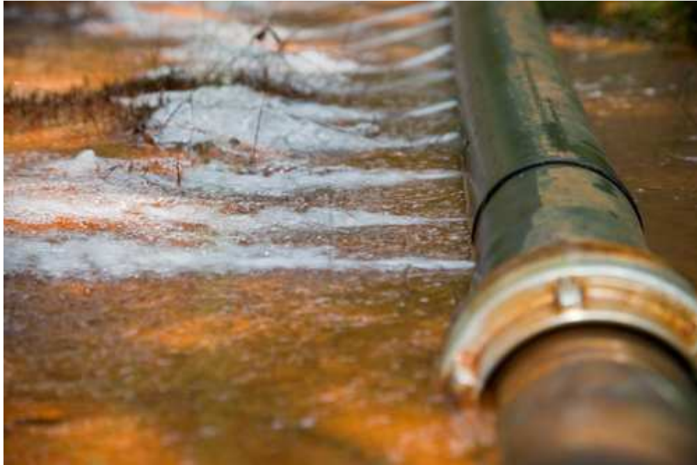
Figur 2.4: Udledning i Grindsted Plantage. Der bemærkes en betydelig okkerfarvning af vegetation og skovbund forårsaget af udfældning af jern.
