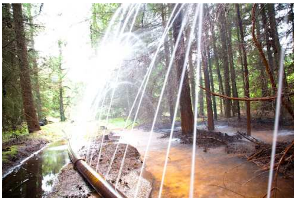
Figur 2.3: Udledningen er gennemført ved sprinkling af vandet over et større areal for at modvirke overfladestrømning og erosion.
